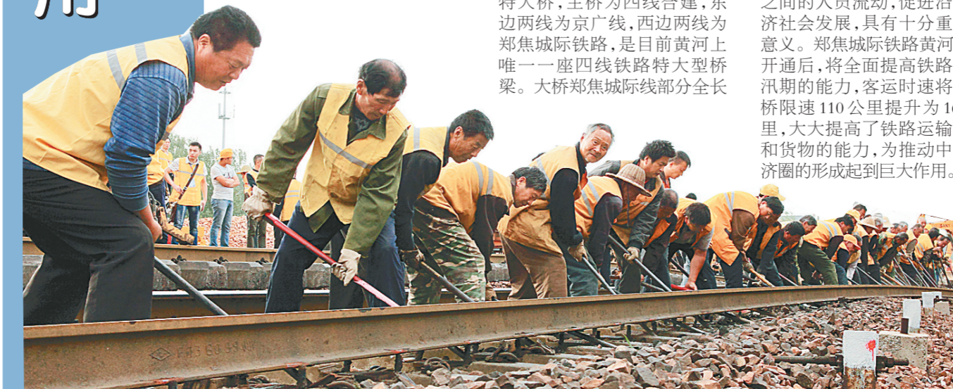
施工人员对京广线新老铁轨进行位移拨接。
