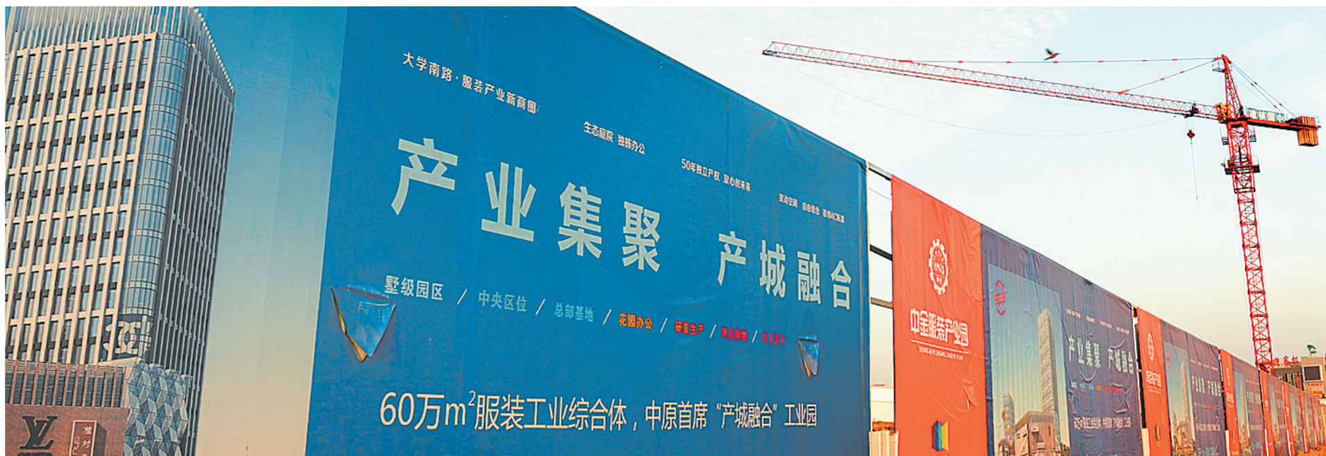
正在建设中的新密市服装产业集聚区。
