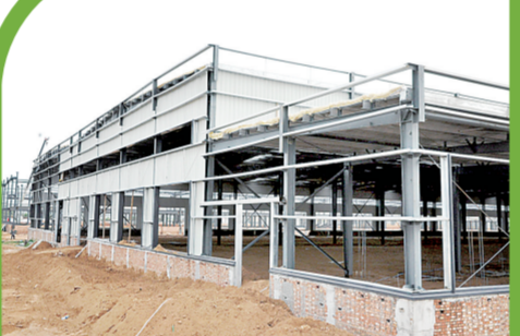
郑州比克电池建设现场。
