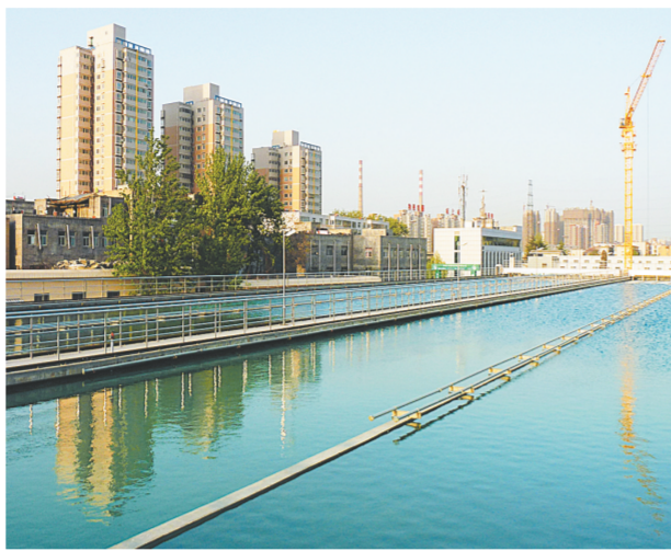
完成深度处理工艺改造后的柿园水厂新貌。
