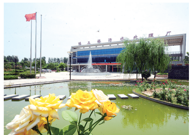
郑州投资控股有限公司子公司——陈三桥污水处理厂新貌。
