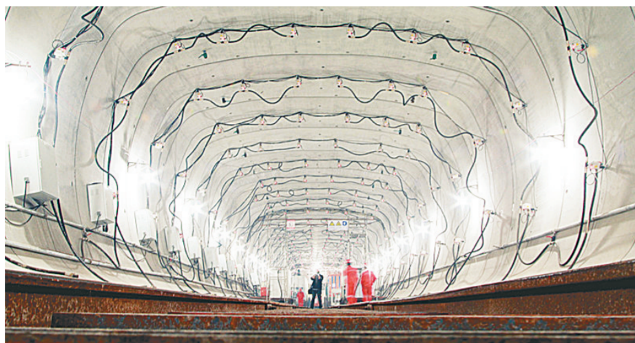
纬四路下穿隧道工程正在施工。
