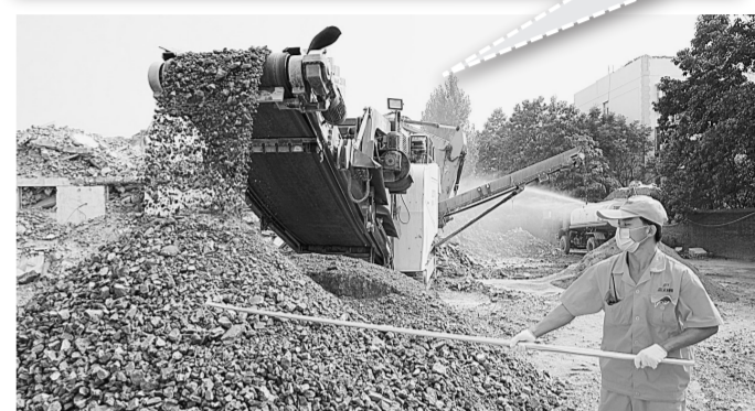
移动破碎机正在对建筑垃圾进行处理。
