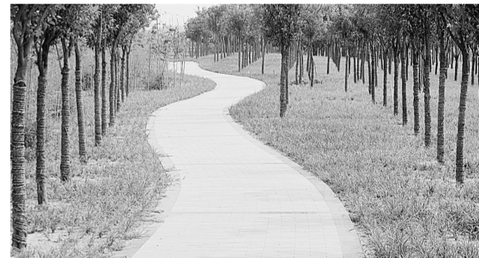
东四环生态廊道上铺设的正是用建筑垃圾制成的路面砖。
