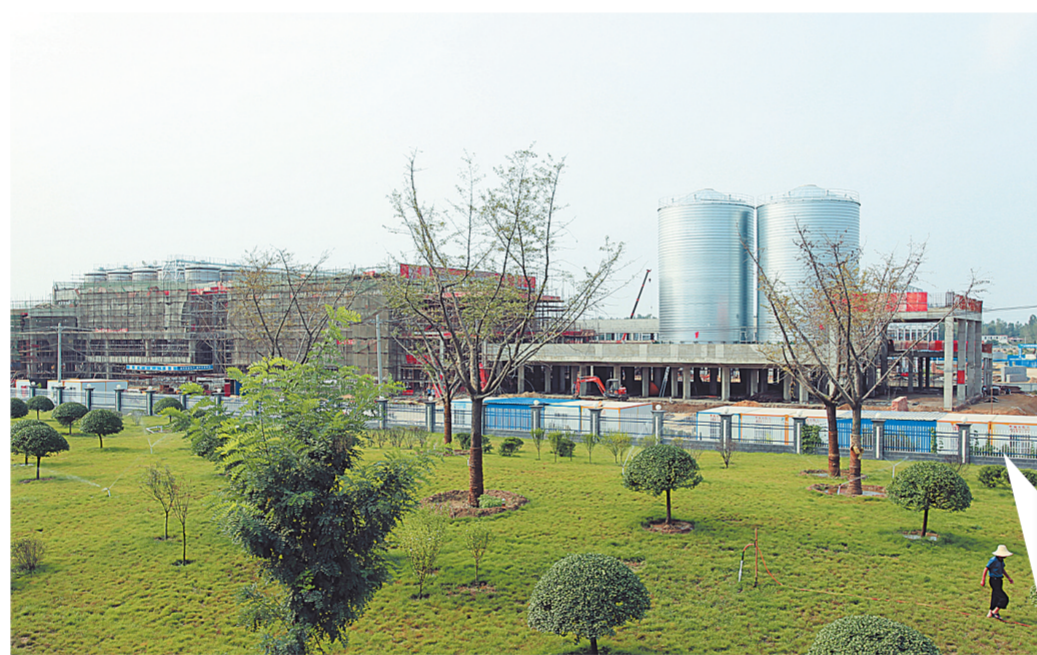
8月25日，位于新郑市薛店镇的华润雪花啤酒(河南)有限公司新建厂房雏形初现。该项目一期总投资人民币9.8亿元，是华润雪花啤酒在河南最大的生产基地，也是按照新的物流运作方式规划设计的花园式现代化工厂。 本报记者 刘栓阳 摄
