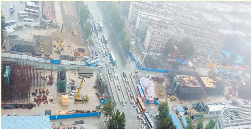
本报讯(记者 张倩 文 宋晔图)昨日，记者从陇海路快速通道工程指挥部了解到，截至目前，陇海路快速通道全线已完成桩基9210根，占总量的90.9%；完成承台1760个，占总量的74%；完成墩台1551个，占总量的64.5%；箱梁浇筑完成196联，占总量的32.1%。此外，陇海路全线的电力线网已经全部入地，整个快速通道工程已进入最后的冲刺施工阶段，按照计划，陇海路高架桥将于2015年春节前建成通车。
