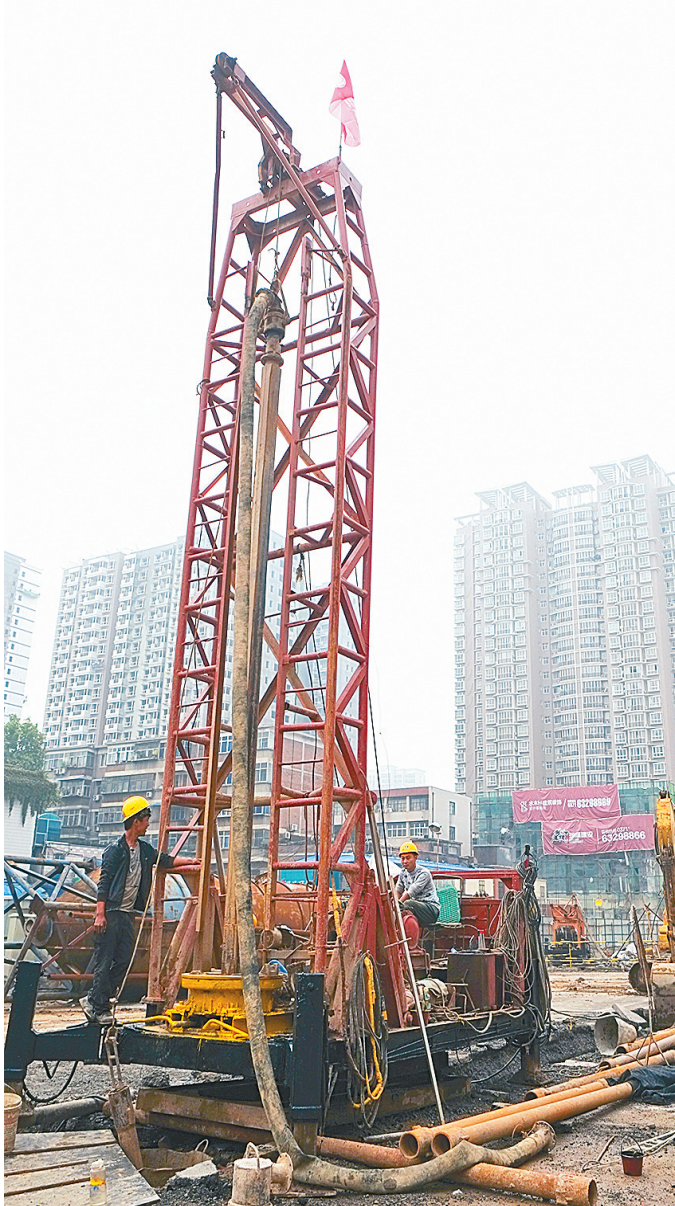
大雨刚停,施工人员就在工地上忙碌起来。
