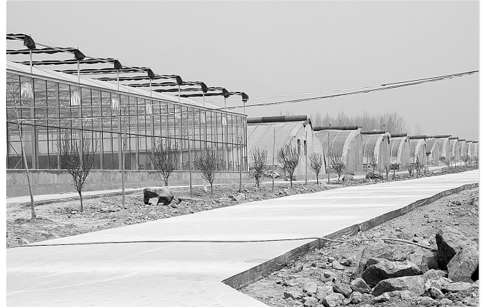
建设中的搬迁群众创业园
