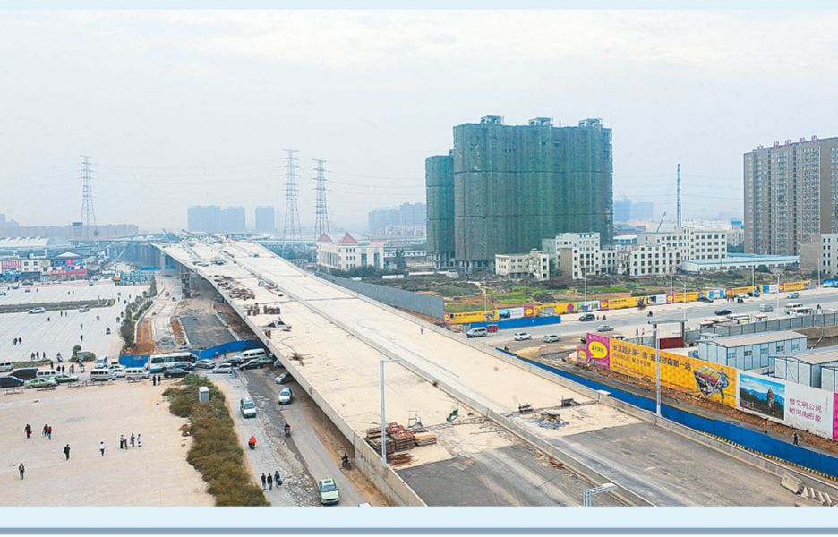
南三环京广快速路全互通立交桥最后5联箱梁17日全部浇筑完毕,标志着立交桥主体结构顺利完工。(详见二版) 本报记者 宋晔摄
