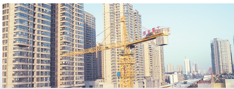
陇海路立交西工区工程。记者 宋晔摄
