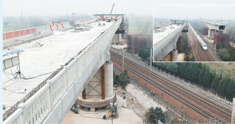
昨日10点30分至11点08分，由中国铁建十七局集团公司承建施工的郑徐客专开兰特大桥跨陇海铁路连续梁转体桥成功对接(大图)。郑徐客专开兰特大桥跨陇海铁路连续梁水平转体工程是双幅逆时针同步转体桥，是郑徐客专全线跨度最大的转体连续梁，该连续梁单墩转体桥总重量约为9500吨，转体桥梁长125米，转体角度为23度。
