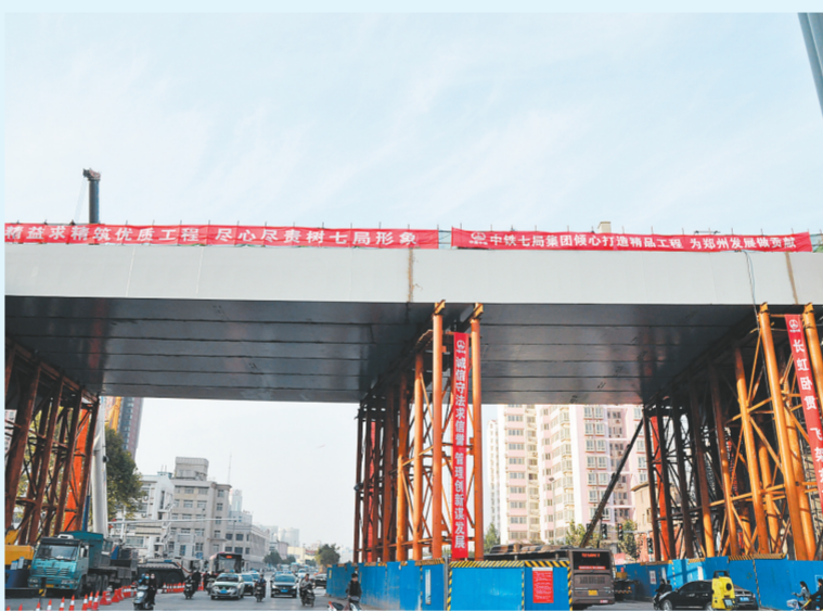
路的钢箱梁现路面有支架支撑,预计本月中旬将拆除。”该负责人表示,拆除后京广路方向道路交通将不再受到施工影响,同时也能一定程度缓解火车站西广场一带的交通压力。
