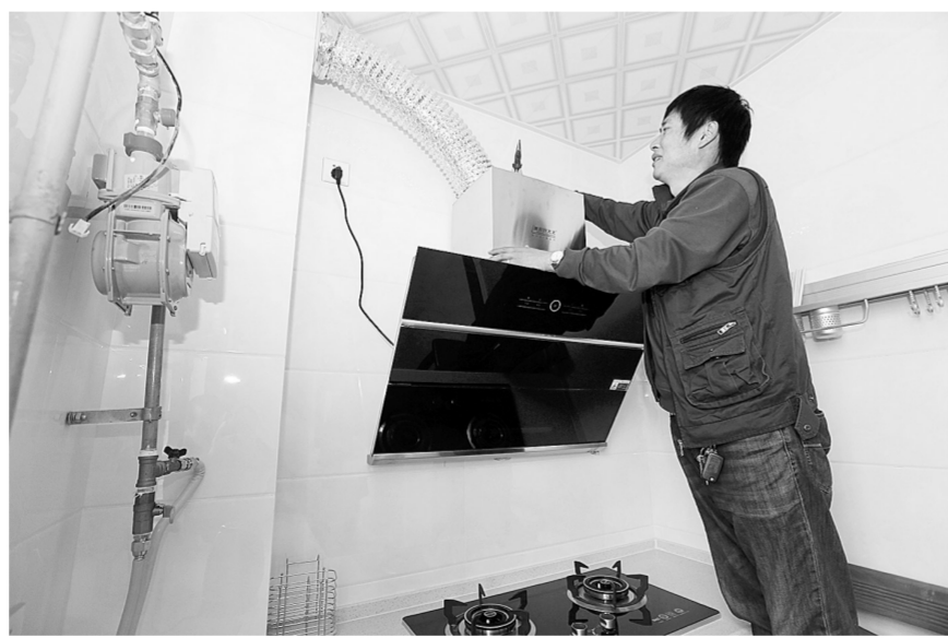
11月5日,新郑市郭店镇中心社区居民乔迁新居,装上抽油烟机。据了解,郭店镇中心社区占地800亩,涉及该镇9个行政村,目前一期工程已顺利竣工,546户居民将陆续迁入新居。二、三期工程也将于11月底和明年3月底封顶完工。 本报记者 李伟彬 摄
