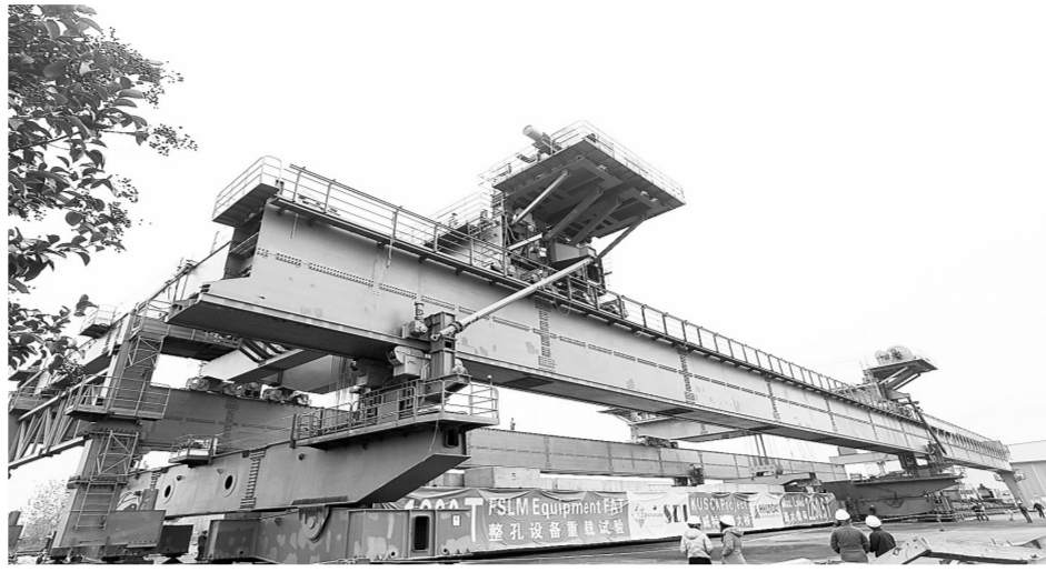
正在进行载荷试验的1800吨架桥机和运梁车
