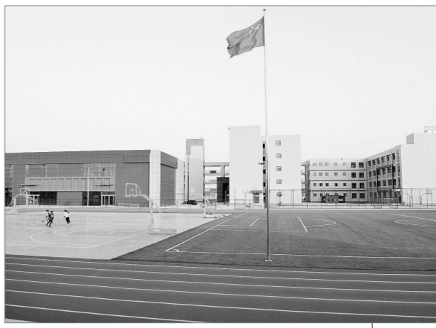
新建的中牟县第六初中设施完备。
