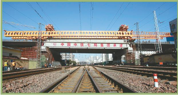
运营,施工的时间点比上跨货运线更为紧张。”陇海路快速通道工程项目部项目经理曹华伟告诉记者,陇海路上跨京广客运营线于本月15日开始架梁,用时一周架设完毕。目前,陇海快速路下穿、上跨京广铁路段主体工程已完成,工程重点将转移至桥面铺设、匝道和地面施工,预计本月28日,该标段将完成沥青摊铺工作,到明年春节前,陇海路主线桥将起到临时保通的作用,把地面车辆引入桥上,对缓解市区交通拥堵现状将起到重要作用。
