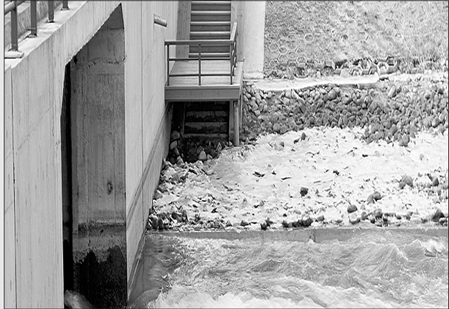
↑12月27日,南水北调中线一期工程总干渠终点团城湖明渠开闸放水。北京市南水北调工程正式通水。
