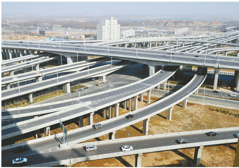
三环快速路与中州大道互通式立交桥。
