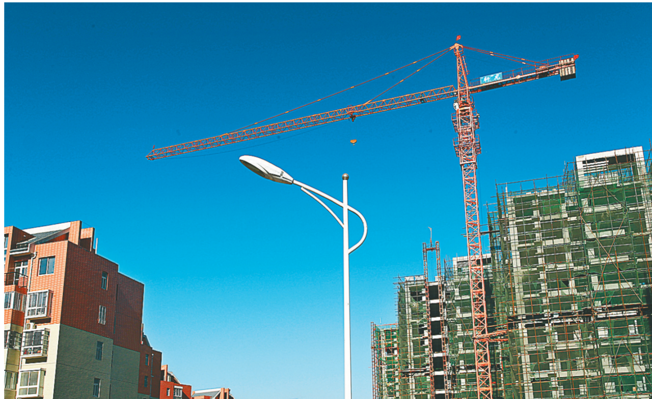
住房是民生之要,发展之需。新郑市始终将解决城市低收入家庭住房困难作为改善民生的着力点,2014年,该市新建保障性住房637套,超额完成年初目标。图为建设中的馨馨苑小区。 本报记者 刘桂阳 摄
