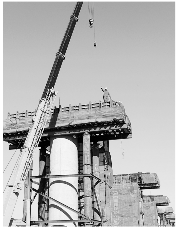
眼下正值寒冬,在新郑,地铁建设者冒着寒风奋战在郑州地铁2号线延长线(新郑龙湖段)建设工地,加班加点、保质保量施工。 本报记者 高凯 摄
