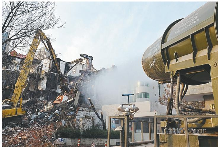
昨日下午,在金水区农业路上,钩机正在进行拆除作业。为把拆迁给市民生活带来的影响降到最低,文化路办事处组织专业的环保除尘风送式喷雾机开进了拆迁现场。
