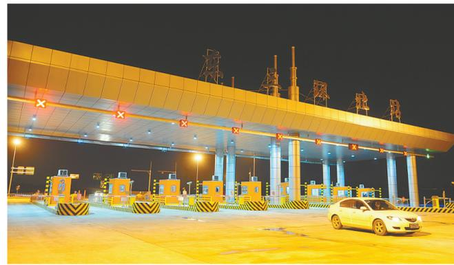
连霍高速东三环北收费站位于现状107辅道与连霍高速交会处,互通式立交主体工程包含了9条匝道,收费站设计为四进六出10条车道,将允许货车通行。该收费站位于环城高速郑州新区站和柳林站之间,今后将成为市区东北方向进出环城高速的重要通道,并将在一定程度上缓解京港澳高速圃田收费站的货车通行压力。
