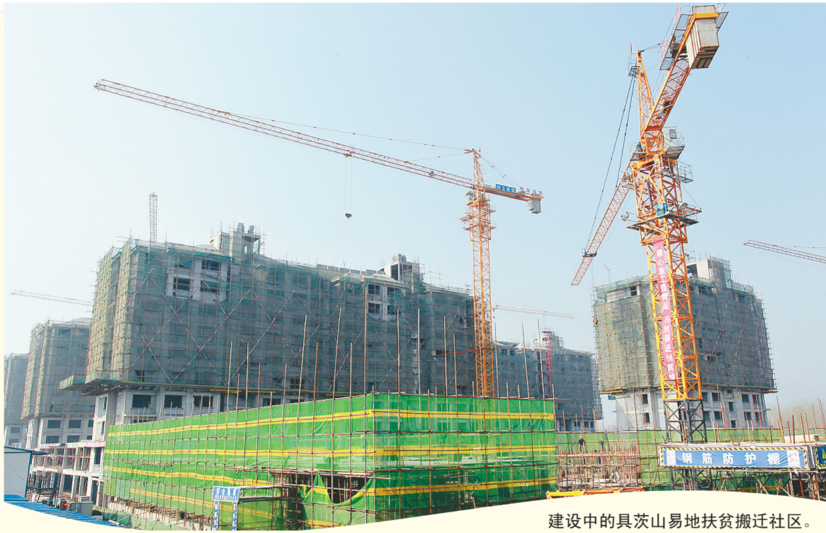
建设中的具茨山易地扶贫搬迁社区。
