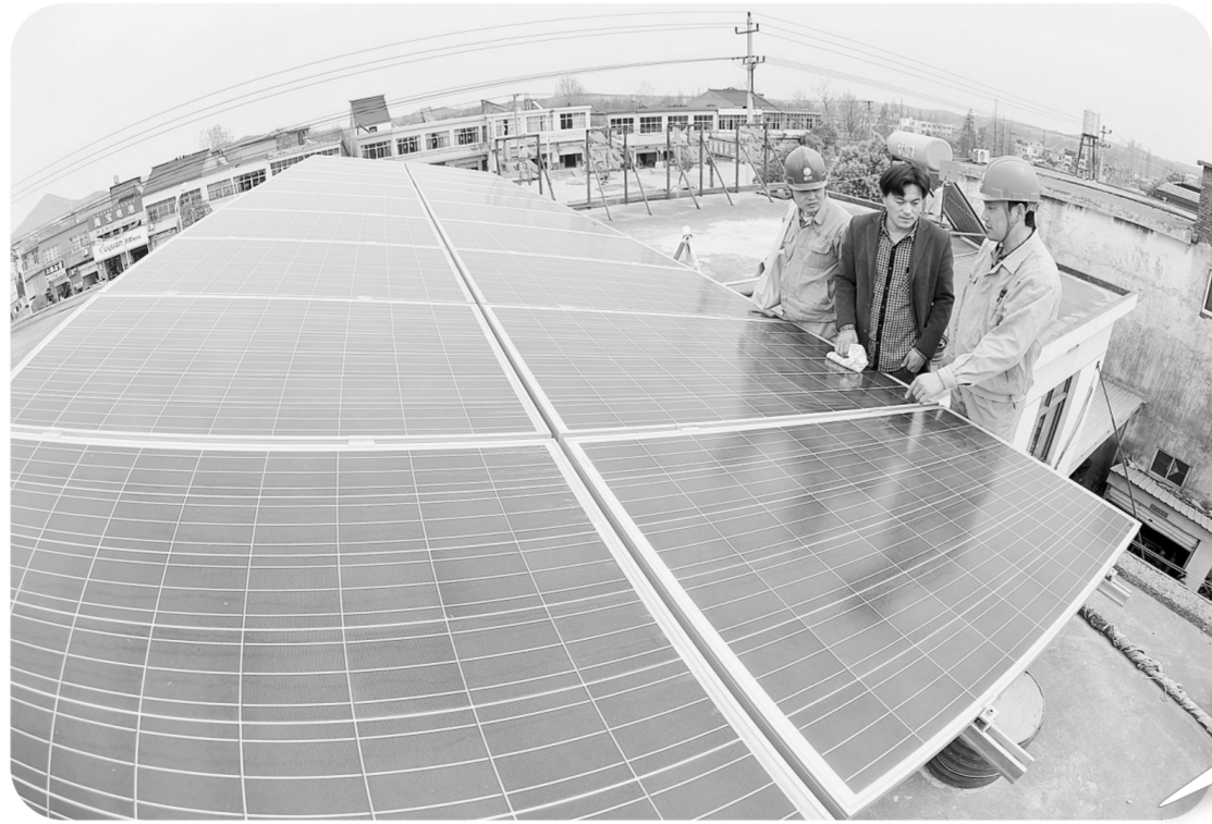
4月9日,庐江电力公司的技术人员在自建光伏发电站的农民曹大(中)家中帮助检查光伏发电设备运行情况。今年起,安徽省合肥市庐江县多户农民自建的太阳能光伏电站正式并网发电。据介绍,安徽省居民自建光伏电站并网发电可享受初期建设补贴、并网电价补贴等帮扶政策。新华社记者 郭晨摄
