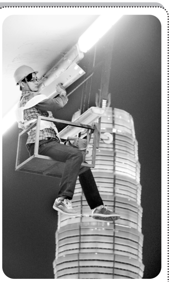
28日夜,工人们将对金水路中州大道立交桥夜景照明灯进行了维修,确保了夜景灯的完好率。 本报记者 裴其娟 摄
