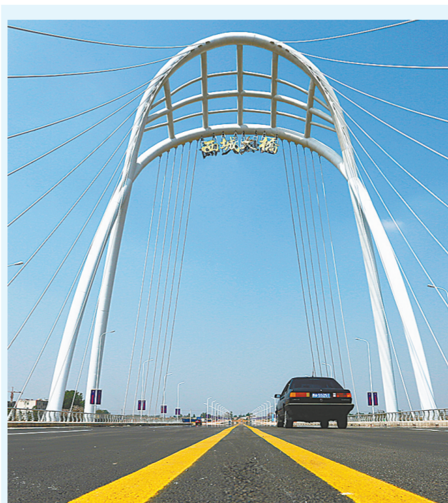
西城大桥是郑韩路跨越双洎河的一座标志性桥梁。该桥全长217米,宽39米,双向六车道。目前工程已完工,达到全面通车条件。
