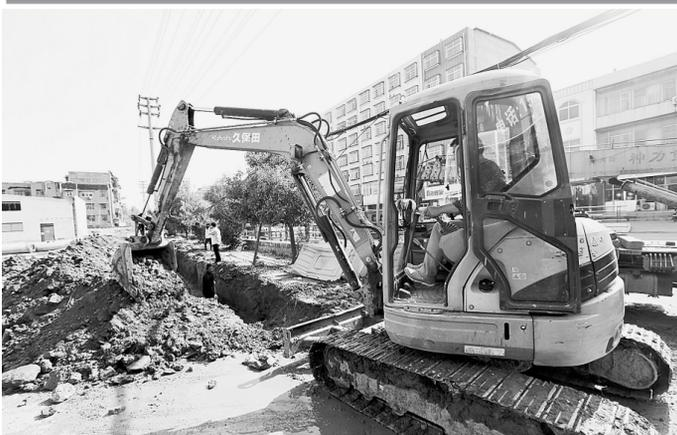
5月8日,工程机械车在新郑市中华北路进行排水管道改造施工。随着夏季汛期的来临,该市对城区涵洞泵站老旧排水管道进行改造,确保雨季泵站排水需要。本报记者 李伟彬 摄
