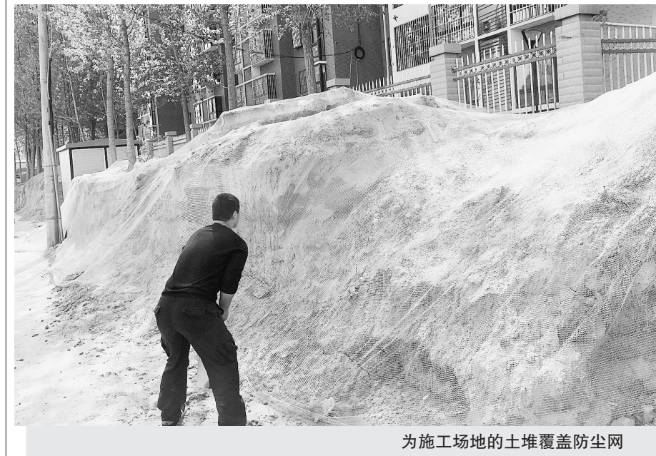
为施工场地的土堆覆盖防尘网
