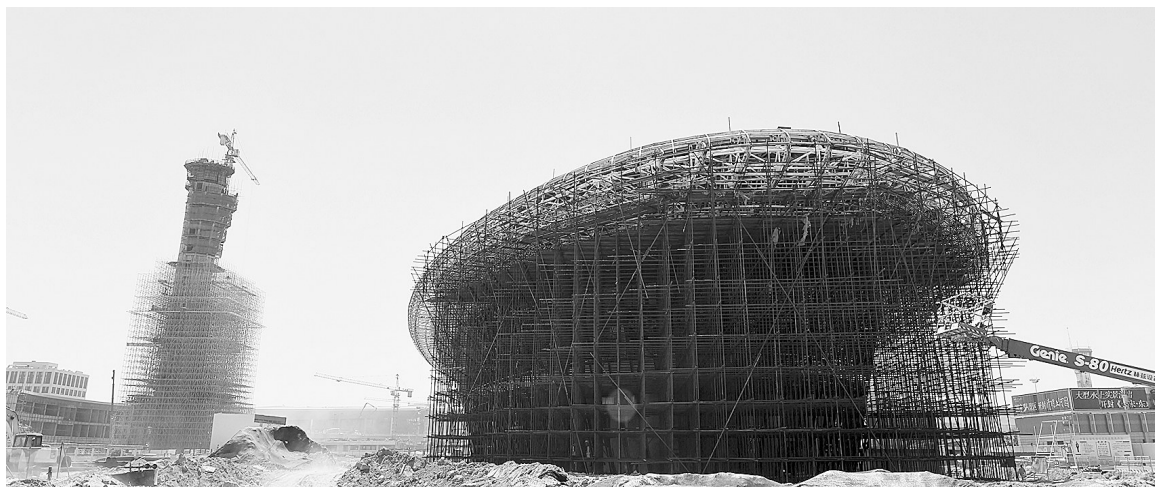
即将竣工的机场二期工程建设现场 郑州报业集团全媒体记者 马健 摄
