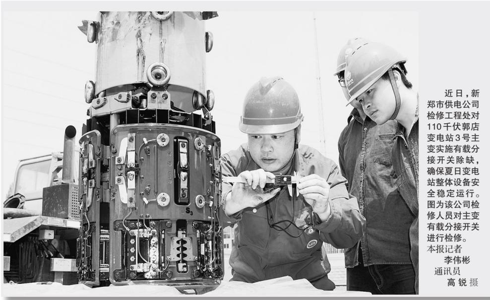
近日,新郑市供电公司检修工程处对110千伏郭店变电站3号主变实施有载分接开关除缺,确保夏日变电站整体设备安全稳定运行。图为该公司检修人员到主变有载分接开关进行检修。本报记者 李伟彬 通讯员 高锐 摄
