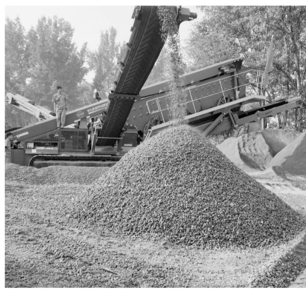
破碎筛分设备正在粉碎建筑垃圾
