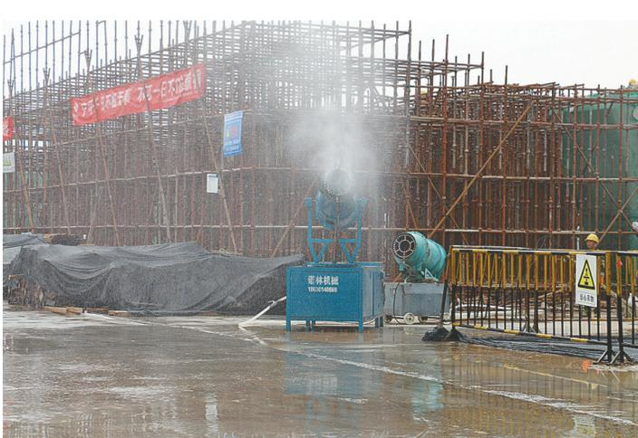
昨日,在农业路一西三环立交工程工地,记者看到,施工现场地面潮湿,不见扬尘。据了解,施工方购买12台喷雾降尘设备,用于施工区域降尘。本报记者 张倩 摄
