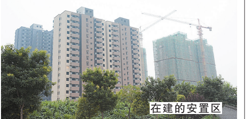
在建的安置区
