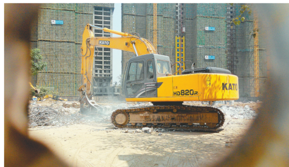
金梭路与玉兰路交叉路口的建筑工地大门紧闭。记者从铁门上的门洞向内望去,只见里面有一台破拆机正在工作,扬起阵阵灰尘。
