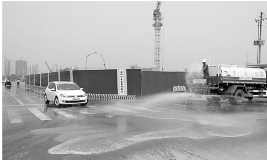
增加场内外洒水频次,抑制扬尘。
