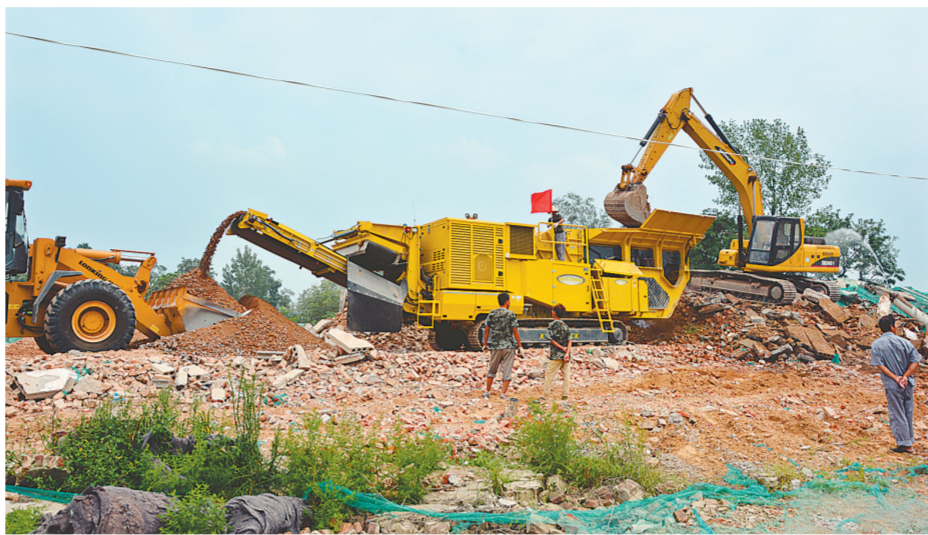
建筑垃圾现场粉碎再利用
