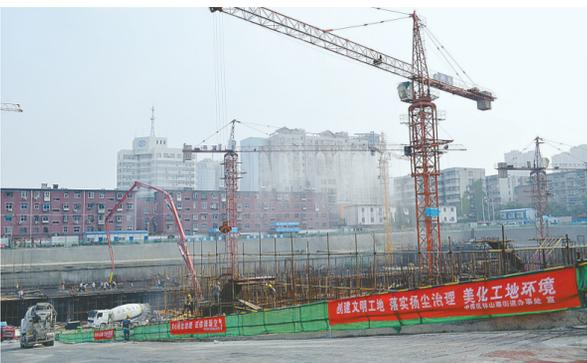
工地塔吊作业边喷雾降尘
