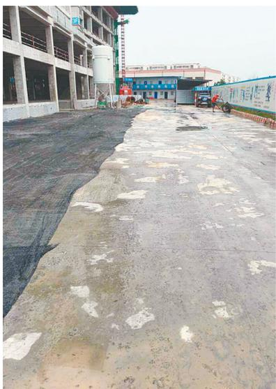
民安·北郡工地将裸露黄土盖上防尘网,道路进行洒水降尘。
