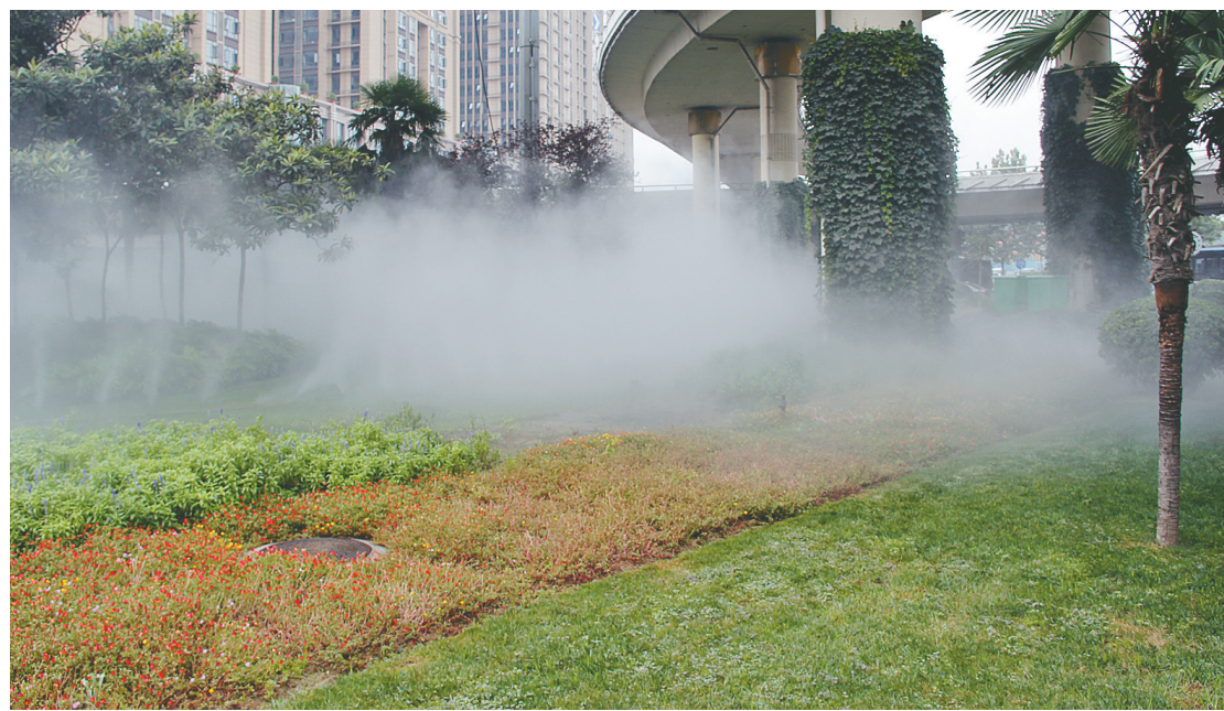
市绿化处在河医转盘游园安装了雾喷装置,定期喷雾防尘降尘。
