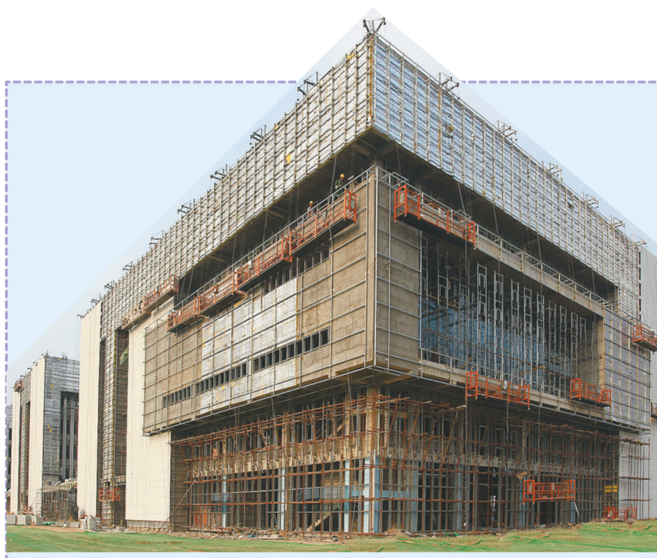
为进一步提升行政服务效能,新郑在完善乡村两级公共服务平台同时,以“全国一流、省内领先”为目标重点打造的行政审批服务中心,现阶段正在加紧施工中,并已完成对工作人员的培训工作。中心投入使用后,将纳入37个具有行政审批权限的职能部门,在服务项目、审批流程、办结时限等方面进行全面优化升级,压减办事流程,让群众办事“只跑一趟路、只进一个门、只找一个人”。
