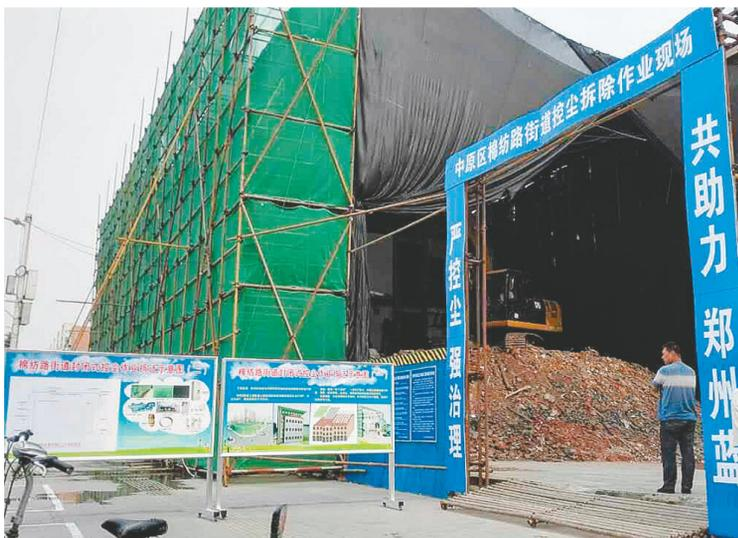
本报讯(记者孙志刚 通讯员刘金利 文/图)市拆除建筑物基本实现无扬尘,工地周边居民、商户不受任何影响。地铁5号线桐柏路站棉纺路街道建筑物拆除工程采用封闭式控尘施工法取得良好效果。
