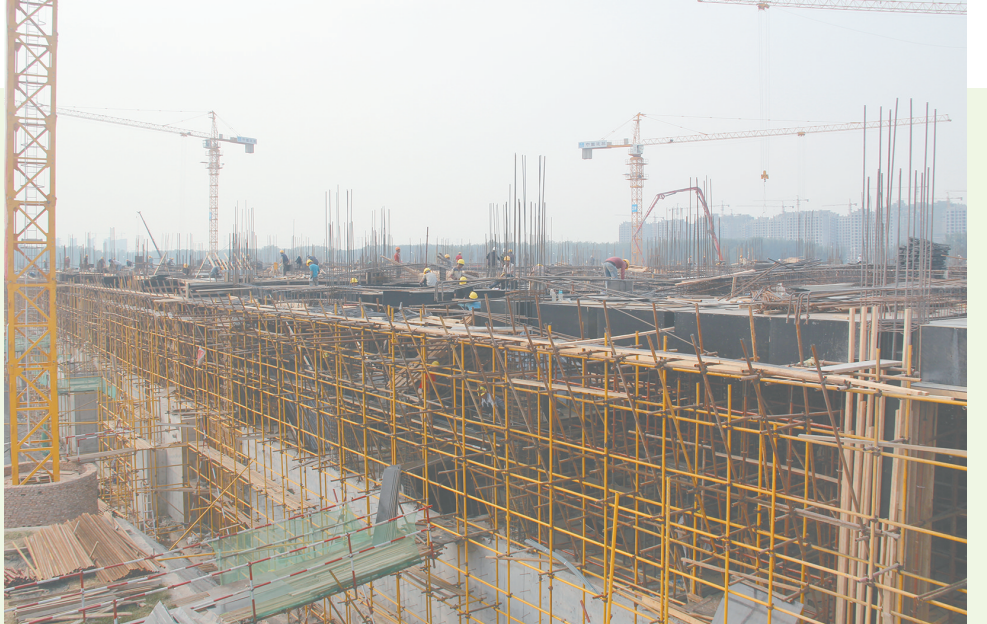
图为繁忙的施工现场。
