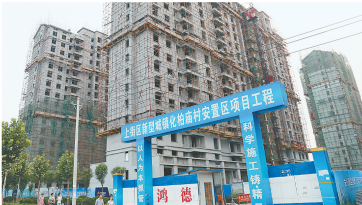
柏庙村安置区项目工程
