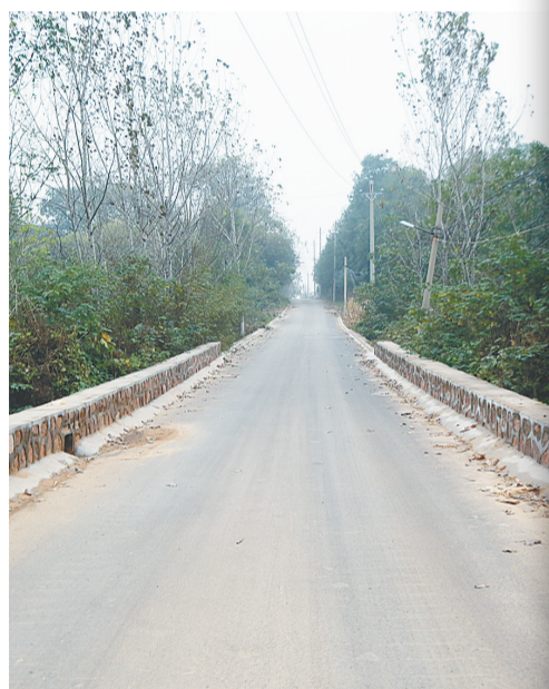
整修道路改善群众生产生活条件。
