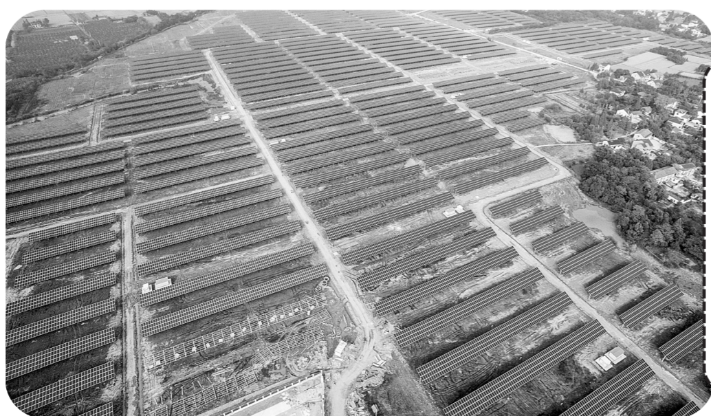
近日，浙江省长兴县东盛光伏农业科技园内占地1460亩的光伏发电工程并网进入试运行阶段。该工程建设光伏农业科技大棚325个，大棚设计为棚上发电、棚下种植喜阴经济作物，实现“一地两用”，是浙江省规模最大的光伏农业示范项目，年发电量可满足9000余户家庭一年的用电需求。新华社发
