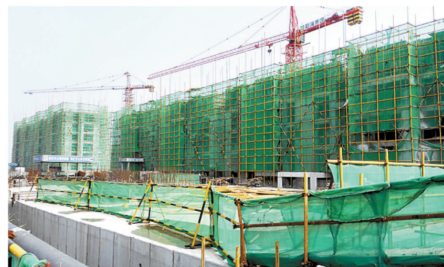
花园口镇安置项目建设如火如荼进行中
