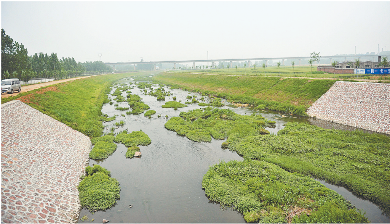
治理后的双泊河超化东至集段河道
